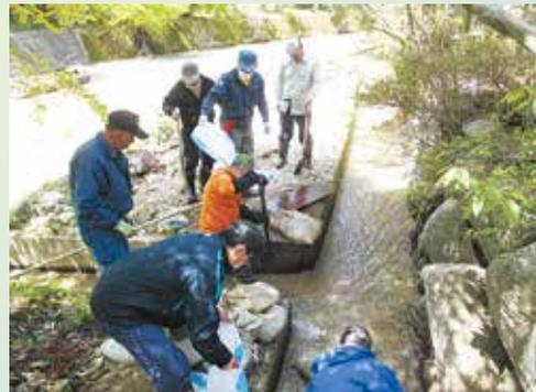
多面的機能支払交付金による水路の補修工事
